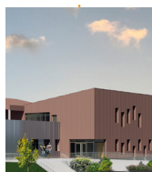
MAISON DE QUARTIER CHÂTILLONS
